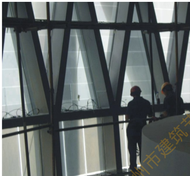
光伏组件现场接线
