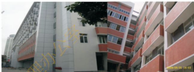
图4-3 改造后外墙实拍图
