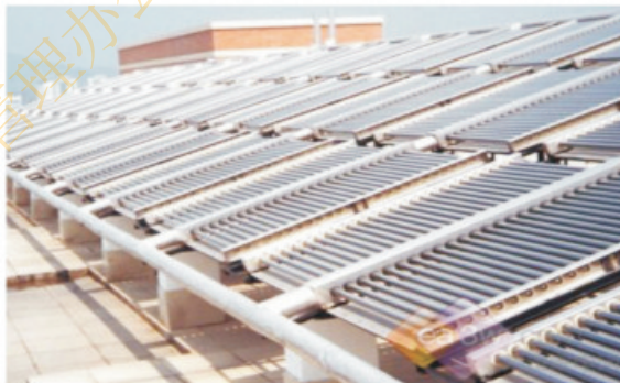
图 2-8 屋面太阳能热水示意图
