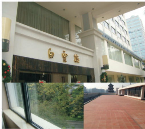
图2-2 改造后外墙、外窗、屋面实拍图
