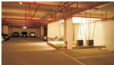
图4-10地下车库采光通风井（地下部分）
