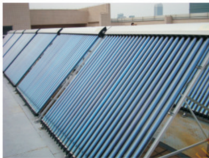
图6-4太阳能集热板实拍图
