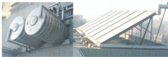
图3-6太阳能光伏发电
