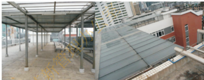
图4-6 太阳能热水系统实拍图
