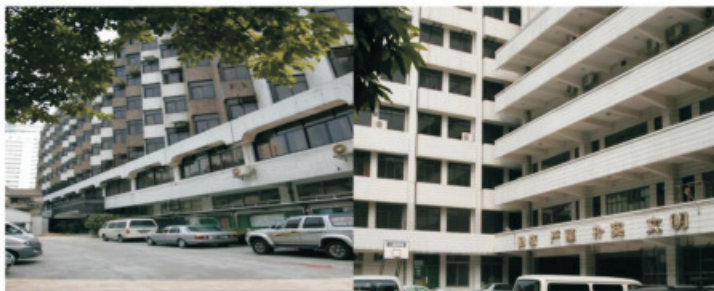
图4-2 改造前外墙实拍图
