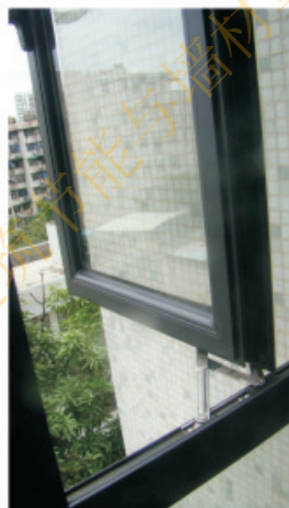
图5-4 改造后南向中空镀膜玻璃窗实拍图
