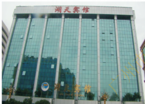
图5-3 改造后北向幕墙实拍图
