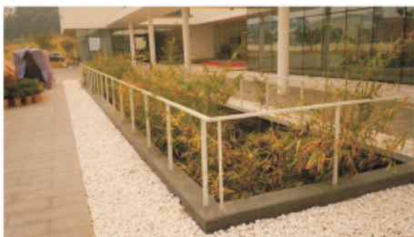
图4-9地下车库采光通风井（地上部分）
