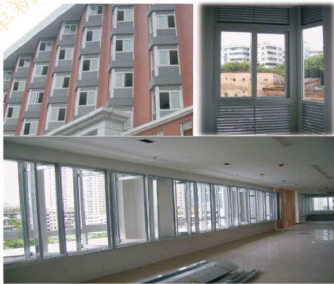
图4-4 改造后外窗实拍图
