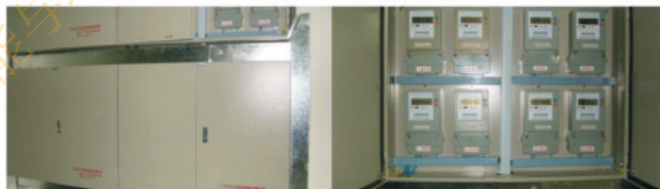
图2-7 分项计量系统实拍图
