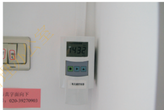
图5-5二氧化碳探测装置
