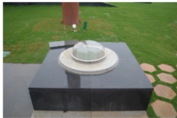
图13 东侧室外光导照明实景图
