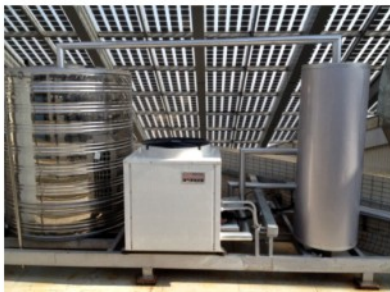
图5 辅助热源（空气源热泵）
