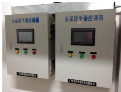
图7 水力平衡装置实拍
