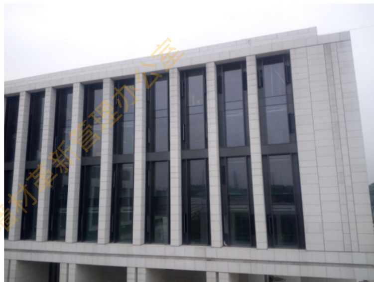
图5 建筑外遮阳实景图
