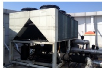
图6 天面风冷(热泵)全热回收机组
