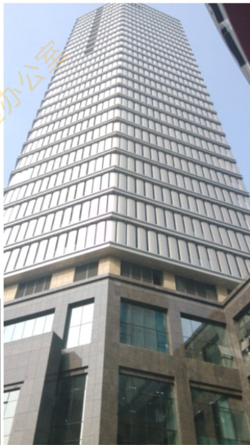
图10 建筑外遮阳现场实景图
