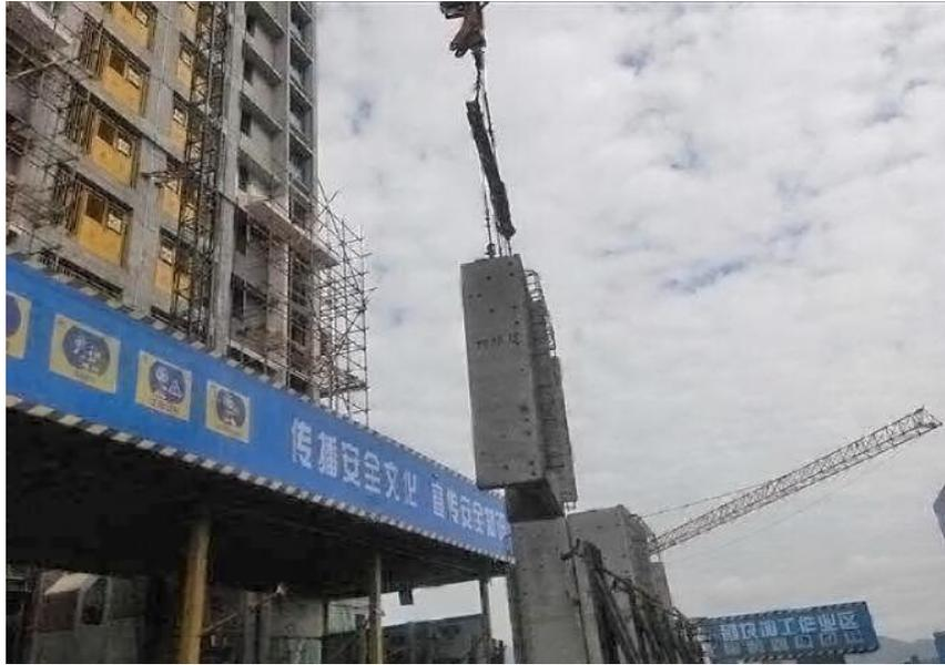
图 3.1 装配式技术施工现场
