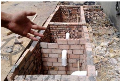
农户雨水蓄水池
