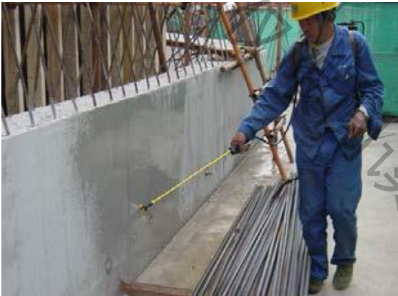
混凝土喷洒养护
