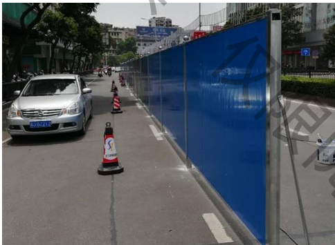
施工现场隔声围挡
