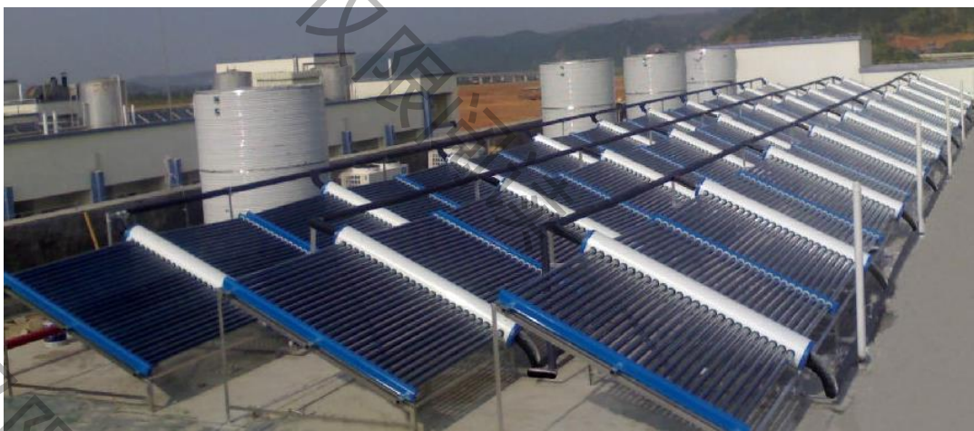
集中式太阳能热水系统示意图
