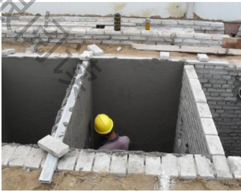
三级化粪池建造
