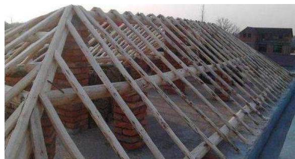
平屋顶改坡屋顶
