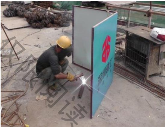
施工安全防护
