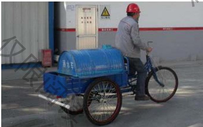
施工现场洒水
