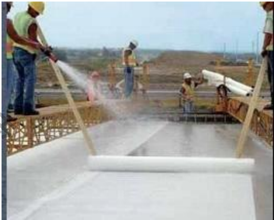
混凝土喷洒养护
