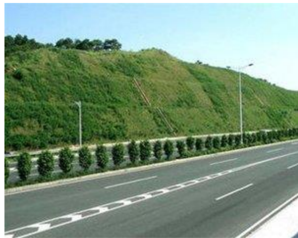
边坡绿化铺装
