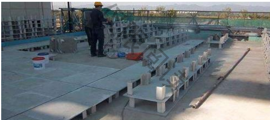
架空隔热屋面实例
