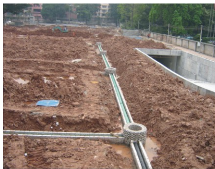
广场雨水收集管道施工实景
