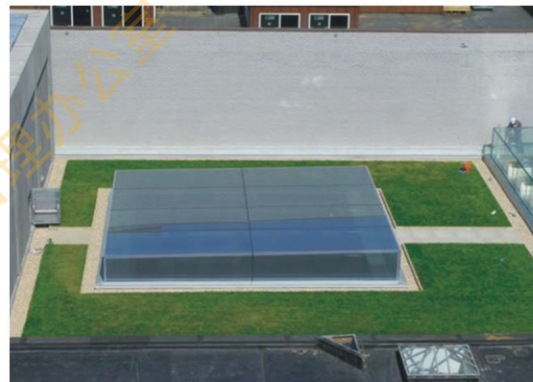
屋面雨水收集实景
