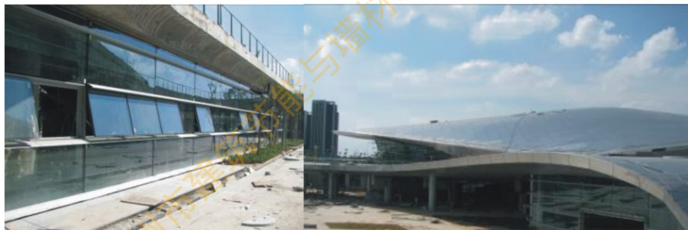
场馆幕墙中空Low-E玻璃安装轻质隔热屋面实景图施工实景
