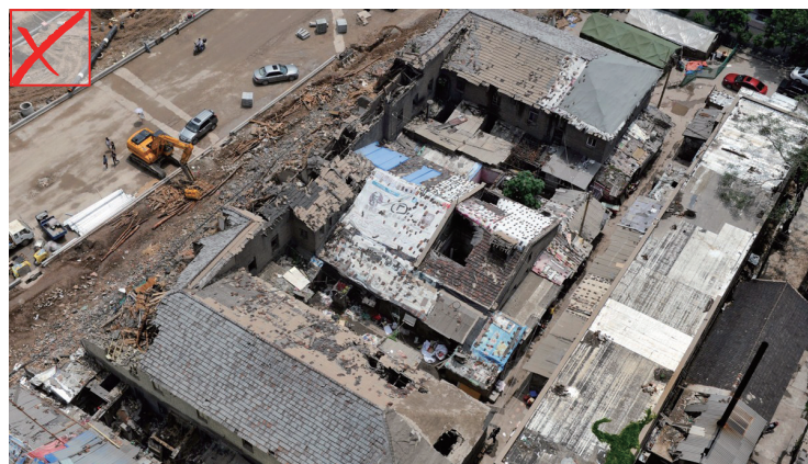
历史建筑被拆除
