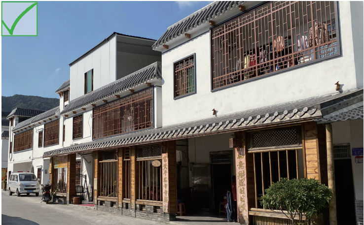
雨棚与外立面风貌修复提升统一考虑，整体协调一致
