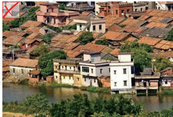
建筑侵占河湖岸线建设
