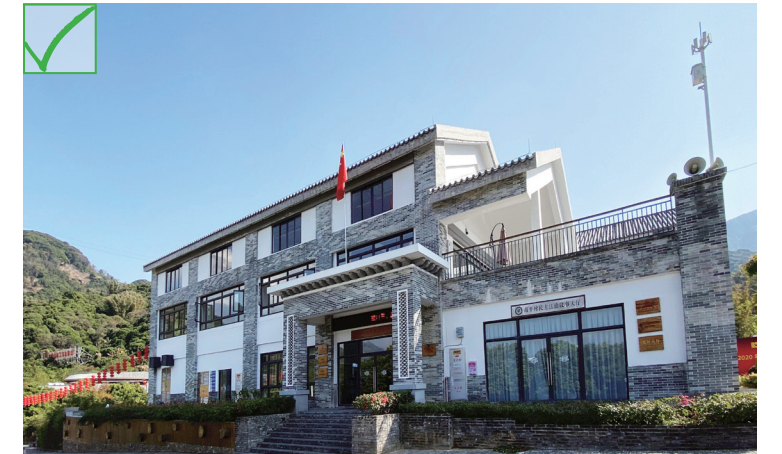
外立面采用青砖贴面和白色涂料，与村庄整体风貌相协调
