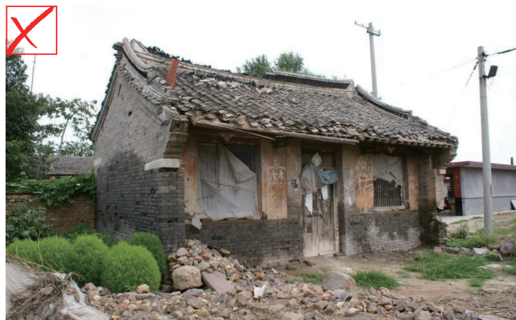
老房老屋被拆除
