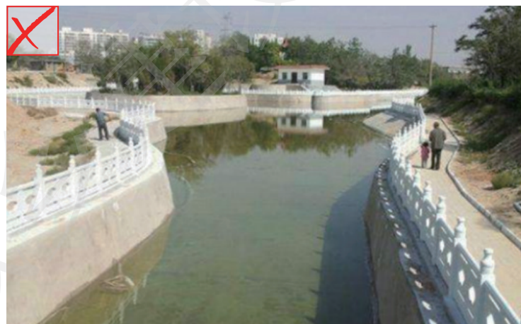
河涌沿岸过度硬化对河流沿岸生态造成破坏
