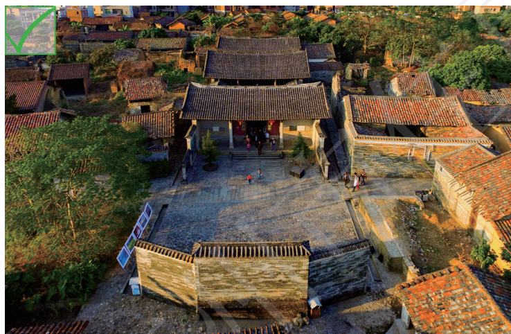
采用青砖等传统材料修复提升祠堂前文化空间
