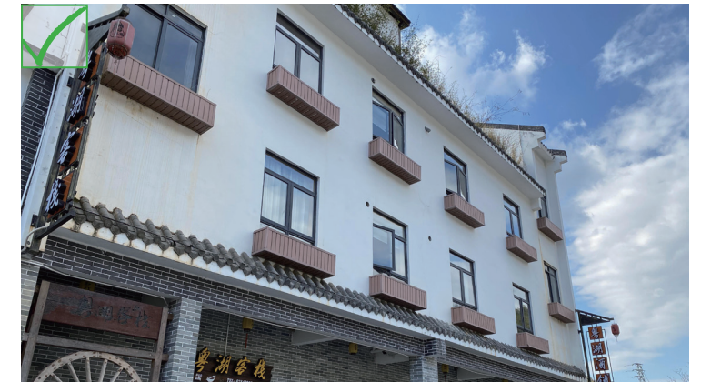
空调外机利用构件进行遮挡，建筑立面干净整洁
