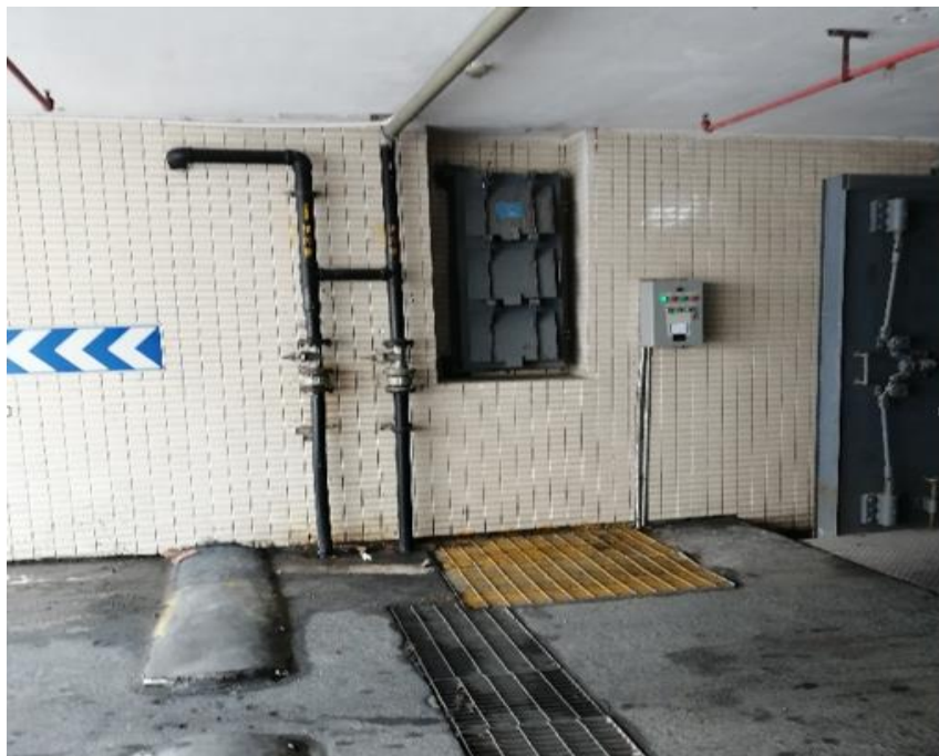
坡道上的悬板活门
