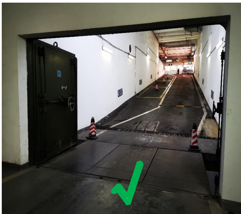
人防门关闭范围安装可活动钢构件
