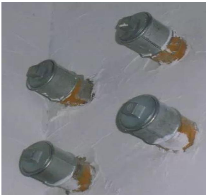
门框墙上预埋空置电线套管的密闭措施
