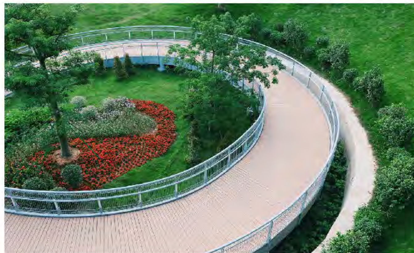
广州“云道” 钢结构无障碍步道
