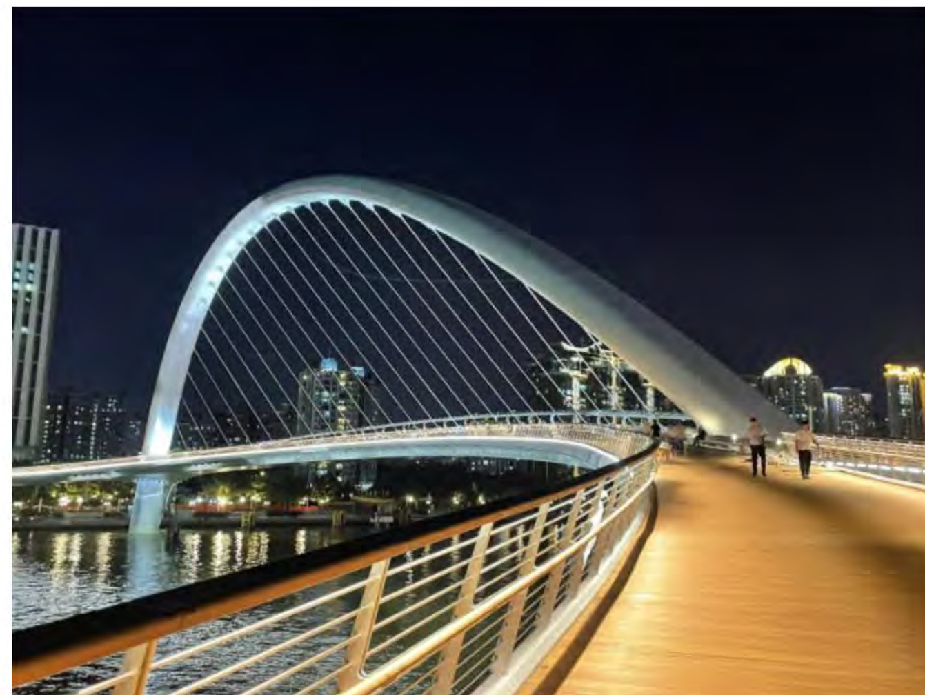
海心桥 轮椅坡道夜间照明
