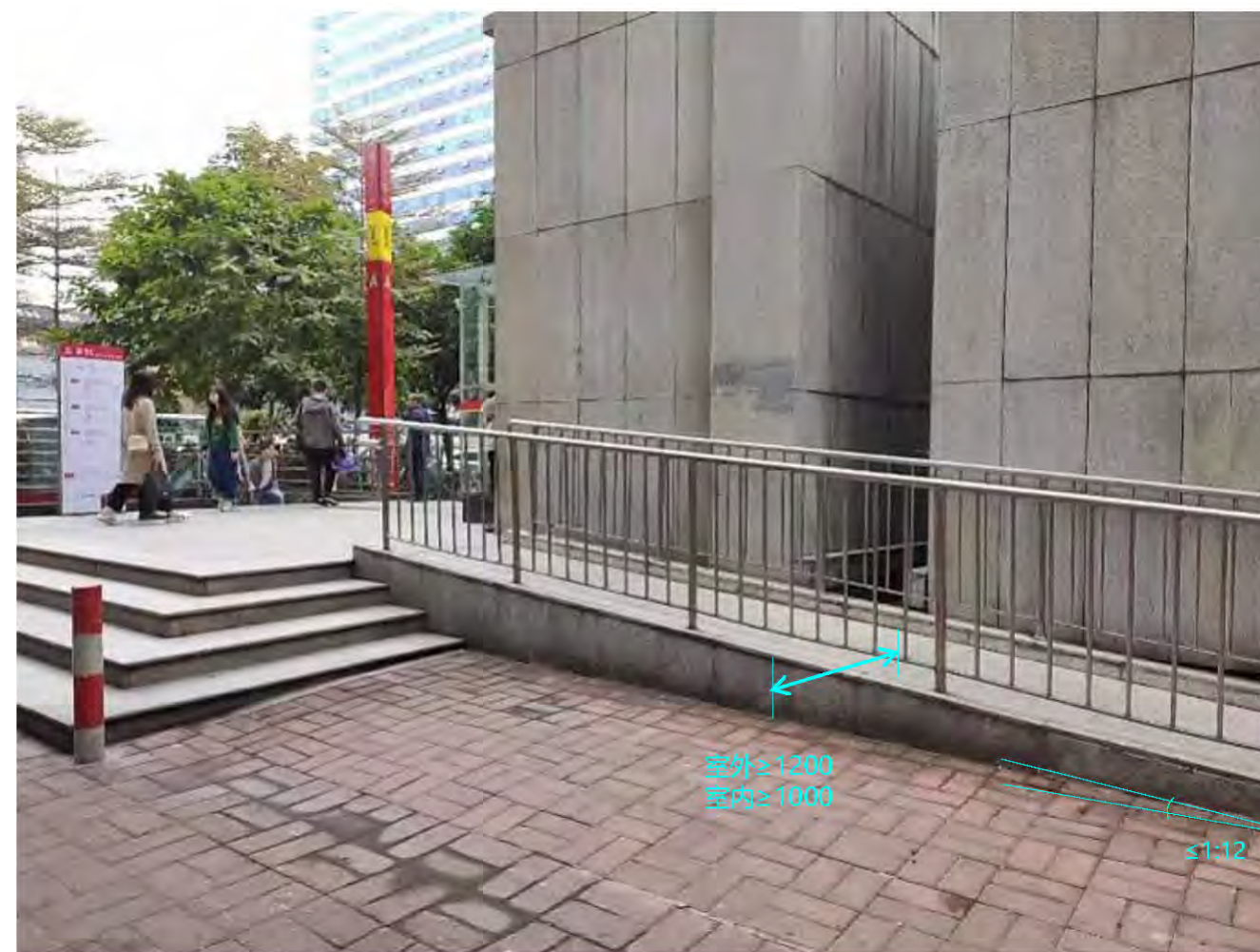
广州地铁出入口轮椅坡道 图片来源：南方都市报
