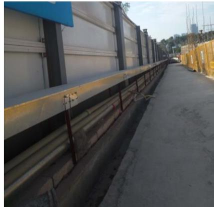
电缆线沿墙壁敷设示意图
