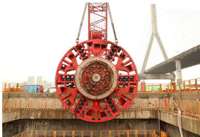
盾构机吊装示意图
