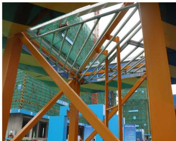
定型化塔吊防攀爬装置1
