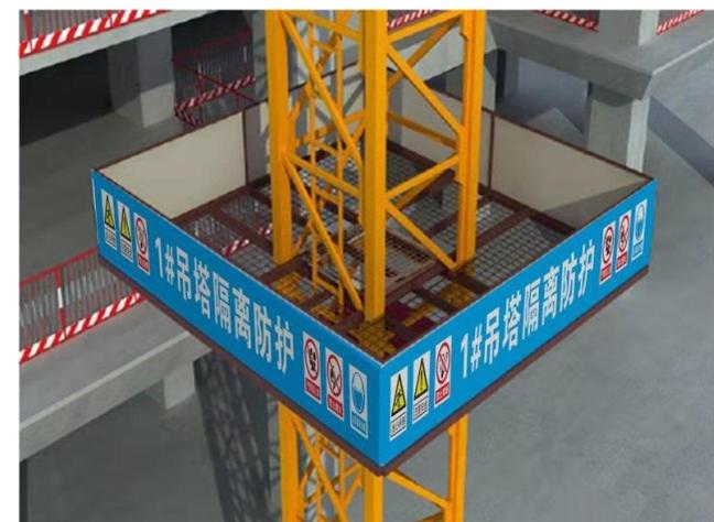
定型化塔吊防攀爬装置2
