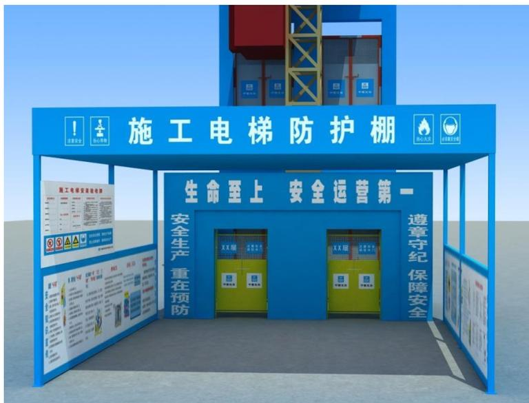
工具式施工电梯防护棚
