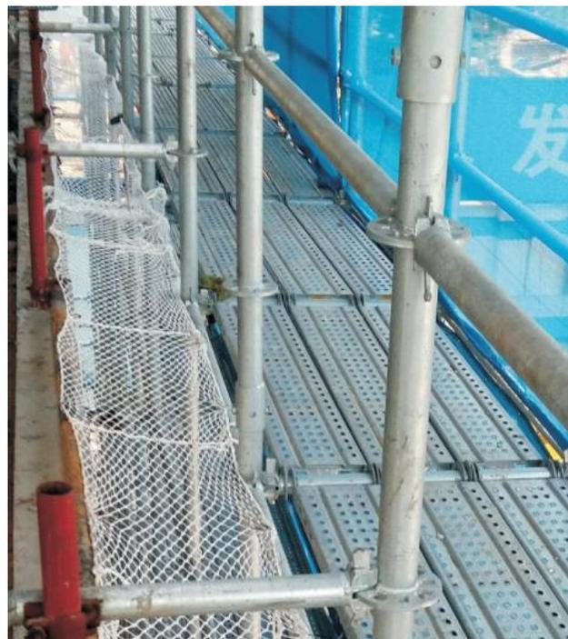
盘扣式脚手架搭设示意图
