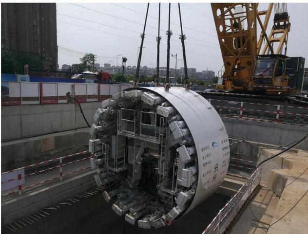
盾构机吊装示意图
