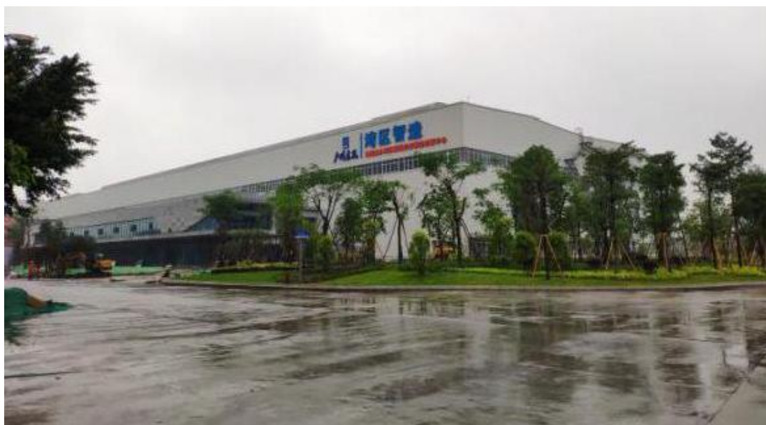
(a) 装配式建筑预制构件生产基地
