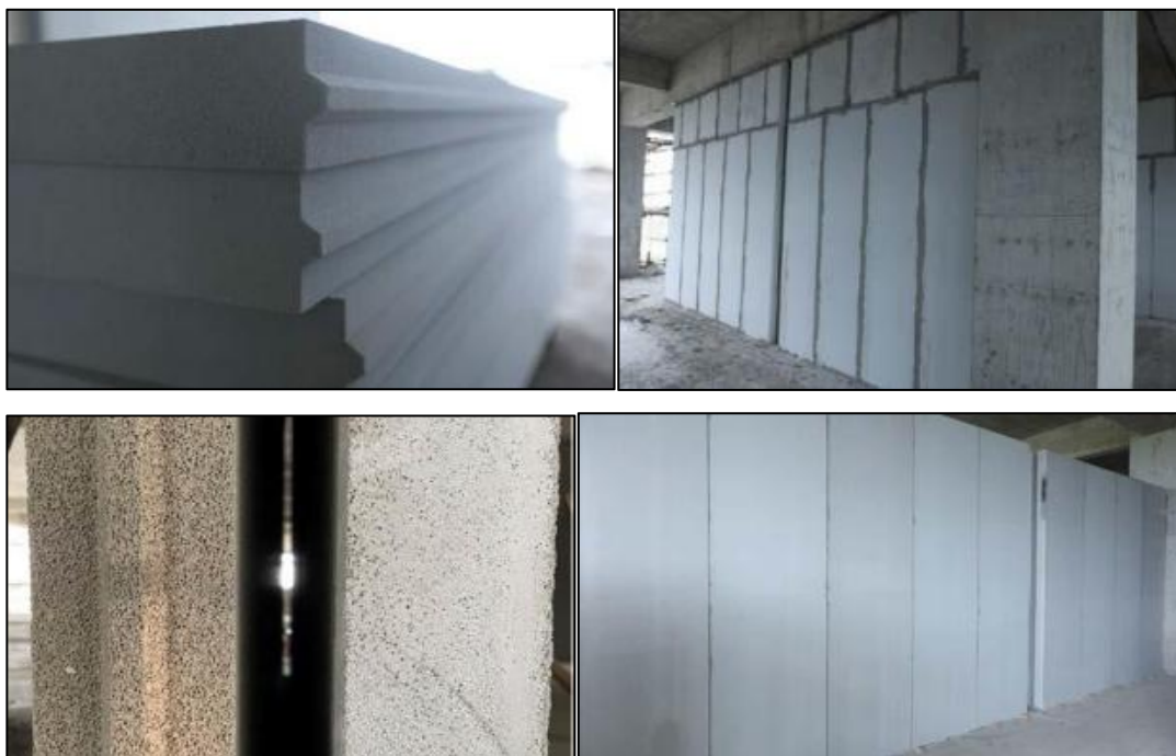
发泡陶瓷隔墙施工
