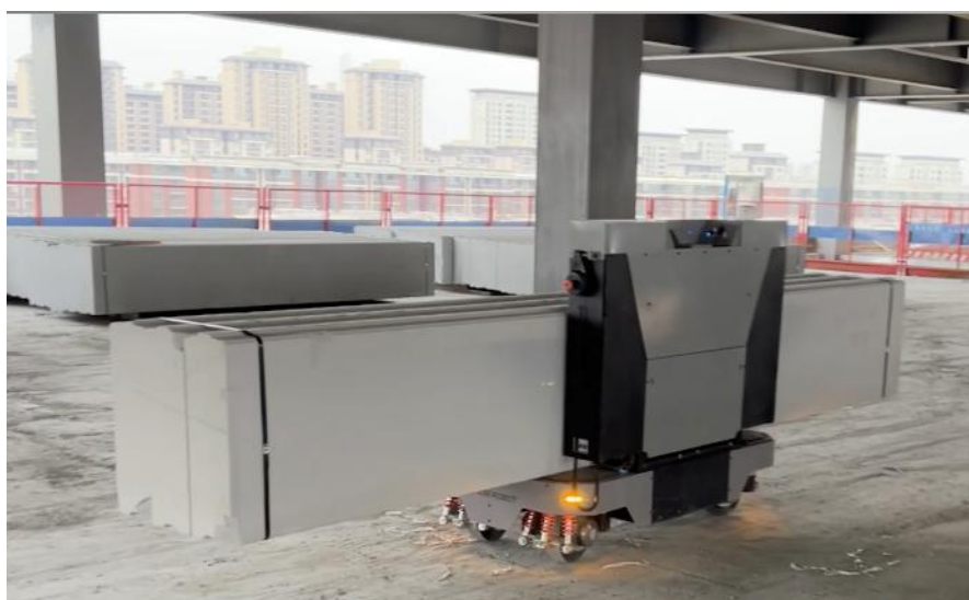
条板搬运机器人现场应用
