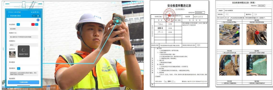
项目安全隐患排查
