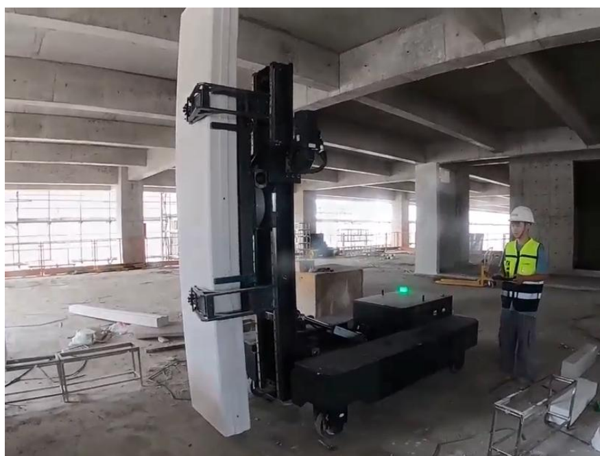
条板安装机器人现场应用
