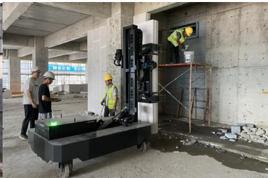
安装机器人现场图
