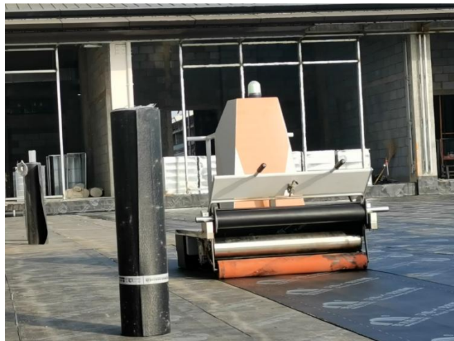
防水卷材机器人现场应用
