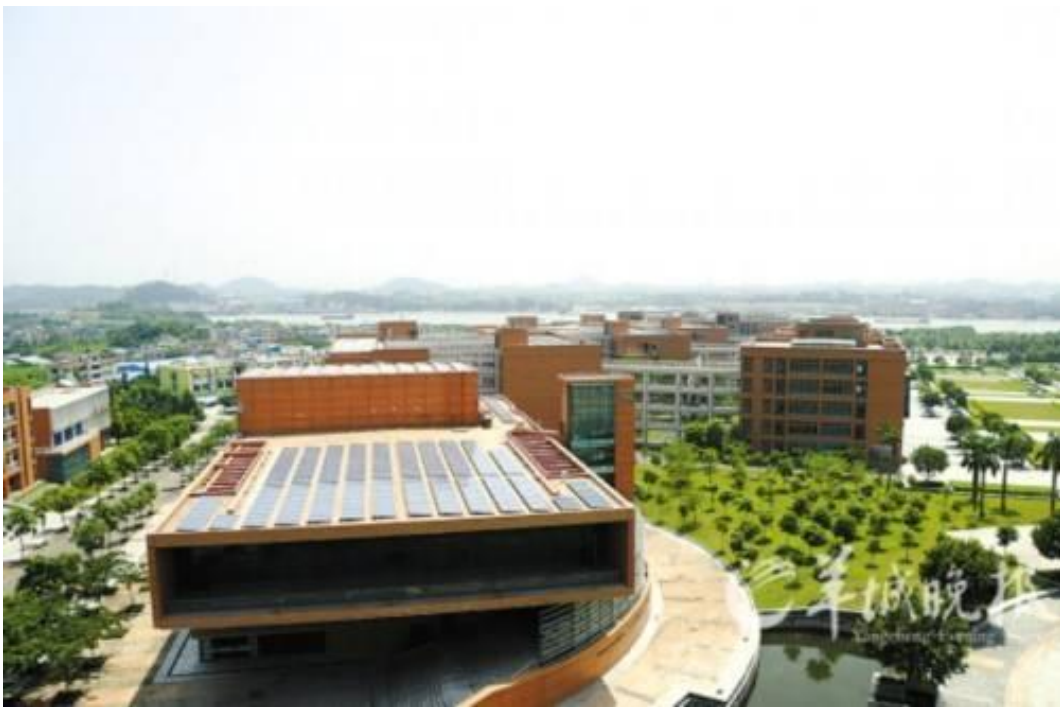
光伏发电项目
