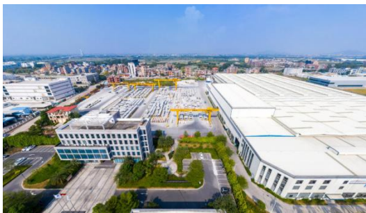
中建智造·东莞基地
