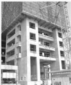
图:使用铝合金模板浇筑的墙体表面平整,精确度高。
