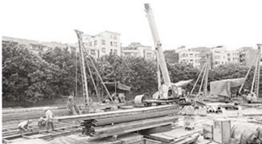
同德围南北高架路完成二标 51-52 轴三台桩机就位
