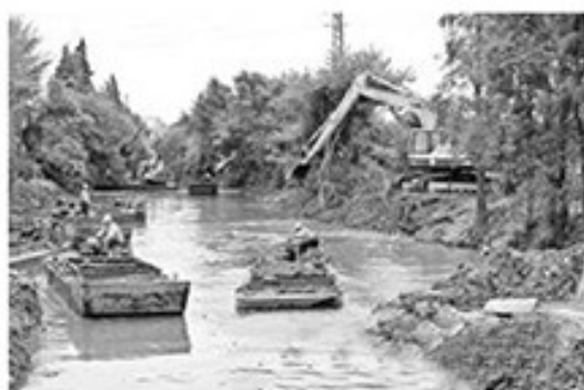
广佛跨界河涌整治现场。
