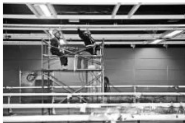
施工中的地铁沙涌站
