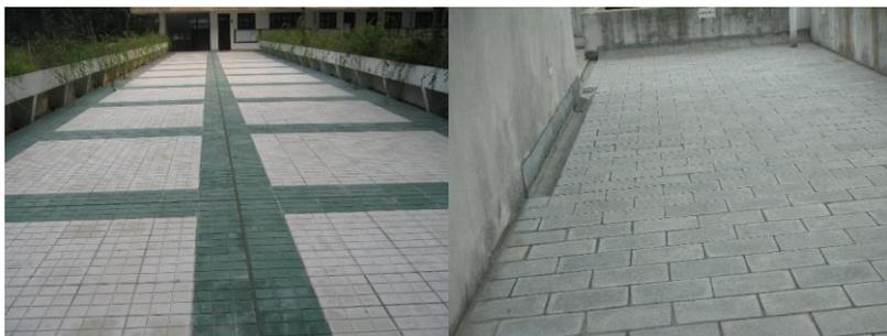
图 3.2 防水型成品隔热板屋面实例
