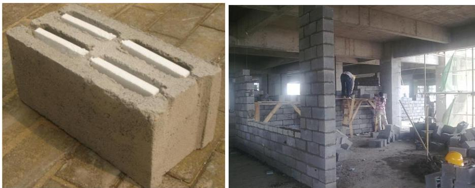
图 3.1 聚苯板插孔混凝土空心砌块及墙体
