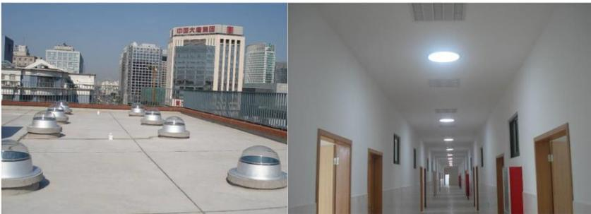
图 3.12 光导管自然采光技术实例
